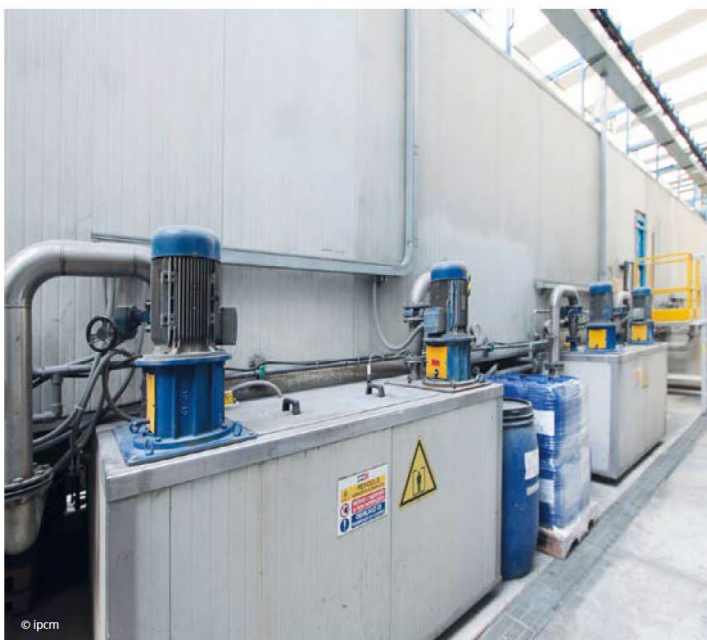
Esterno del tunnel di pretrattamento.
