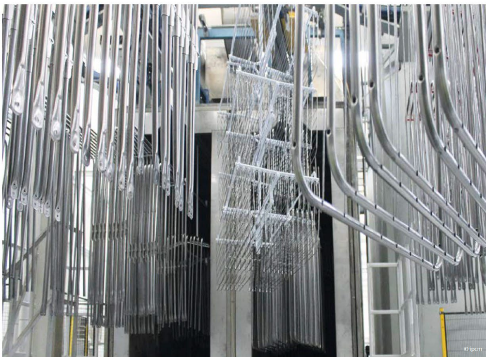
Componenti diversi entrano nel tunnel di pretrattamento.
